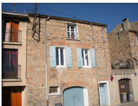
Réseau aérien BT à conducteurs nus en façade
