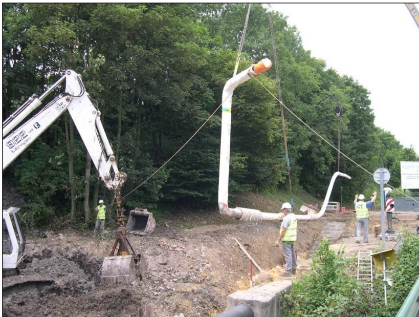
Illustration d'une baïonnette en cours de pose
