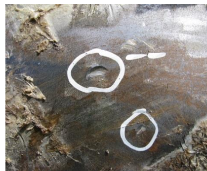
pioche / canalisation acier gaz HP
