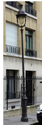
Éclairage public - Luminaire
