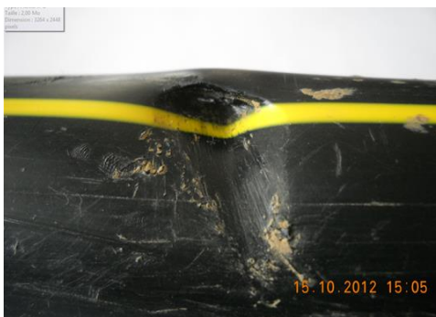
barre à mine / canalisation PEHD gaz MPB
