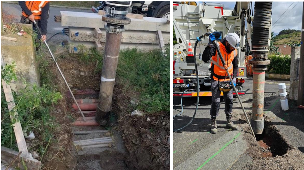
Délitement avec lance à air et aspiration sans contact dans la zone de précaution.
